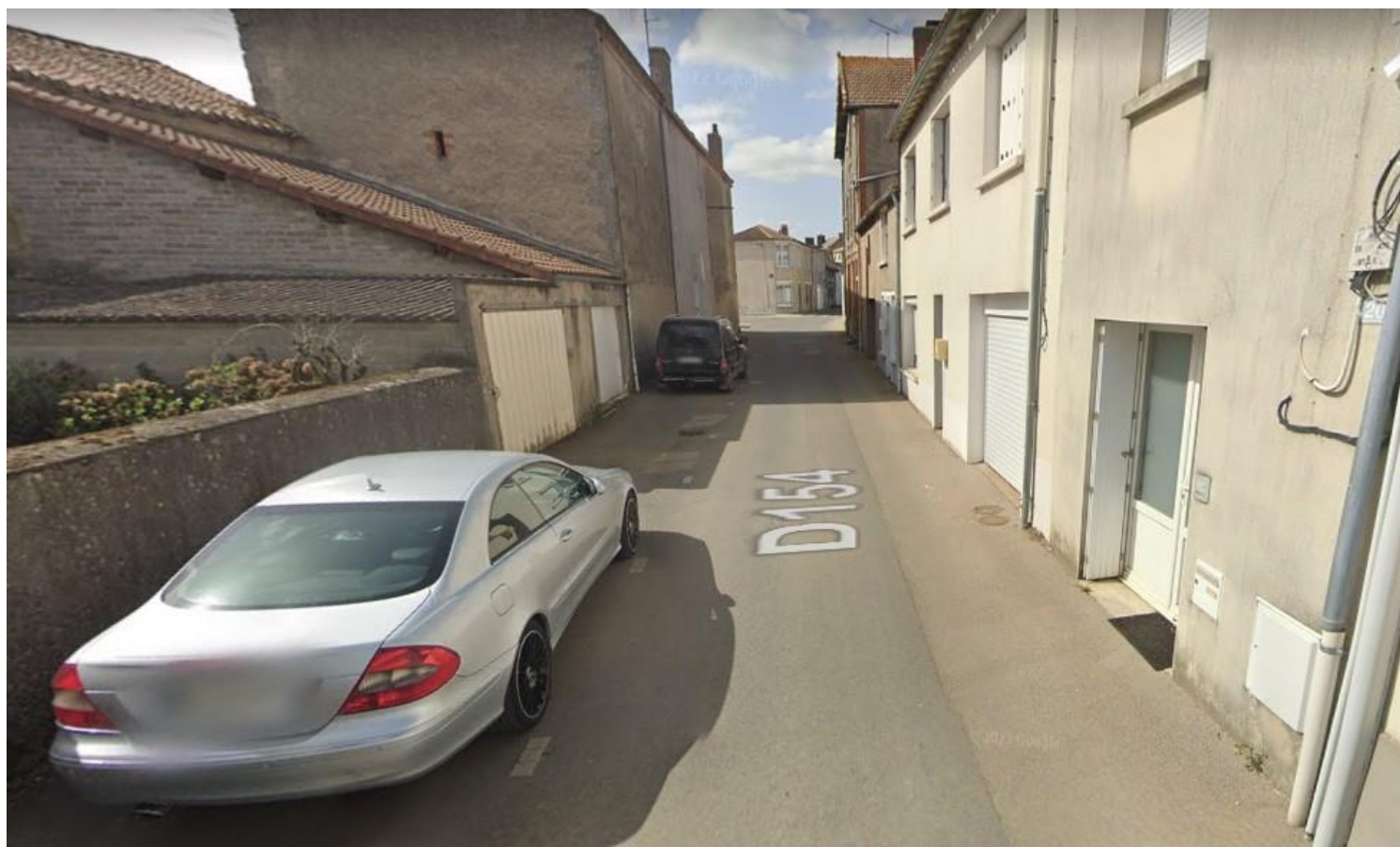
Aménagement Rue du théâtre
