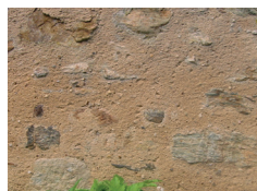
Jointoiement à pierres vues
