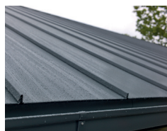
Couverture à joints debouts acier pré-laqué
