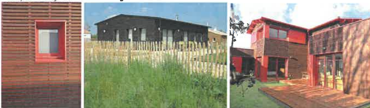
Réalisations : Metisse Architecture - J Fuseau - Bressuire
